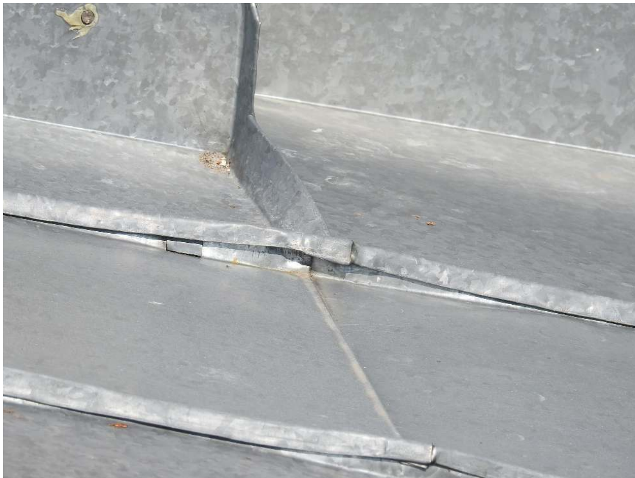
Niedokładne łączenie blach na rąbek stojący.
