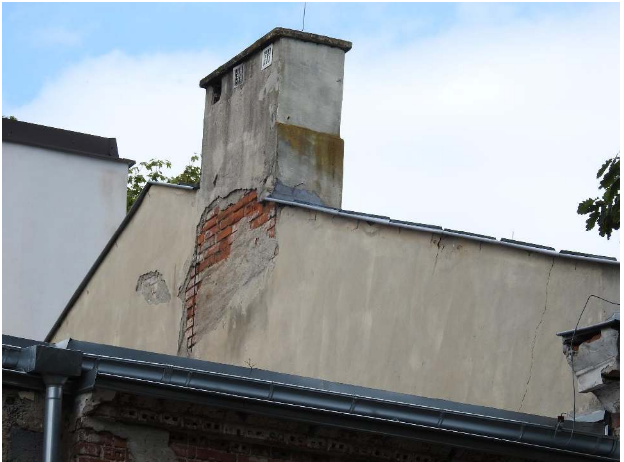
Ubytki tynku.
