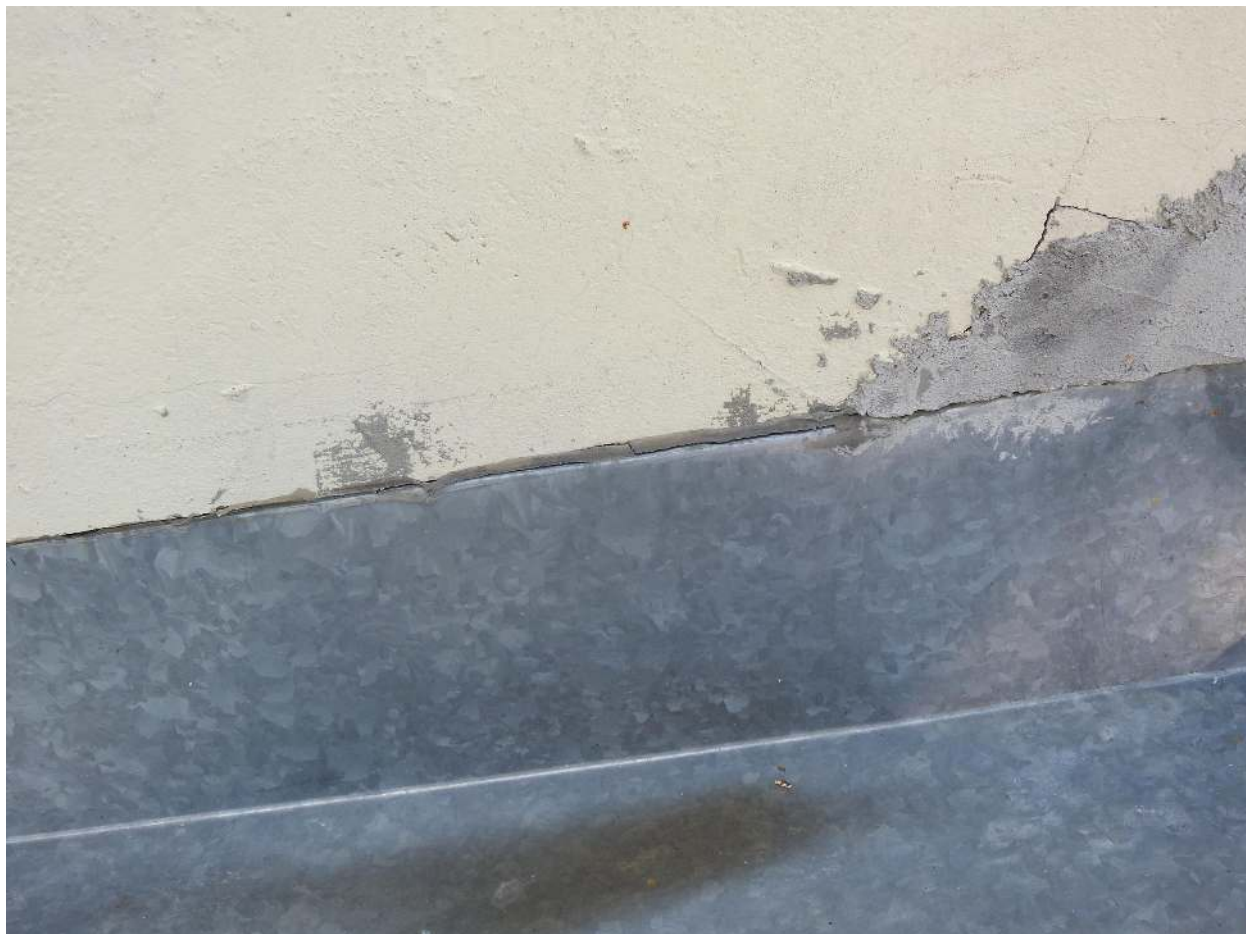
Niefunkcjonujące uszczelnienie.
