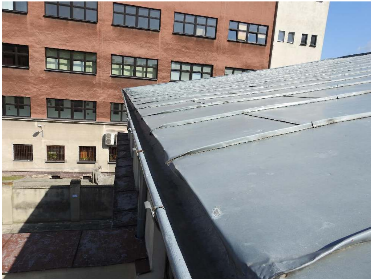
Niedokładne łączenie blach na rąbek stojący.
