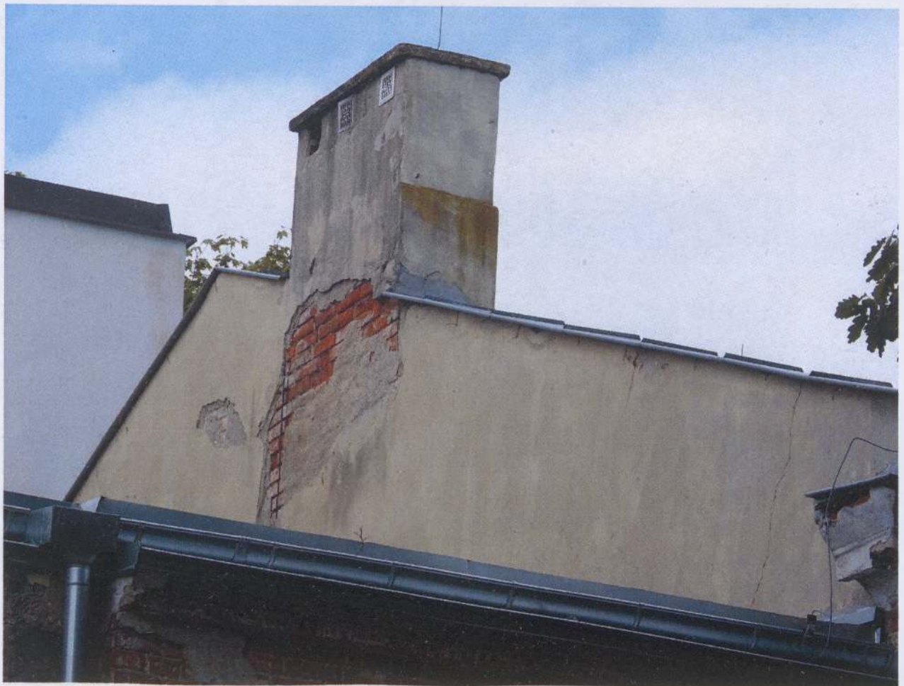
Ubytki tynku.
