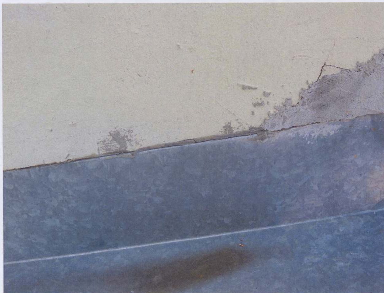
Niefunkcjonujące uszczelnienie.
