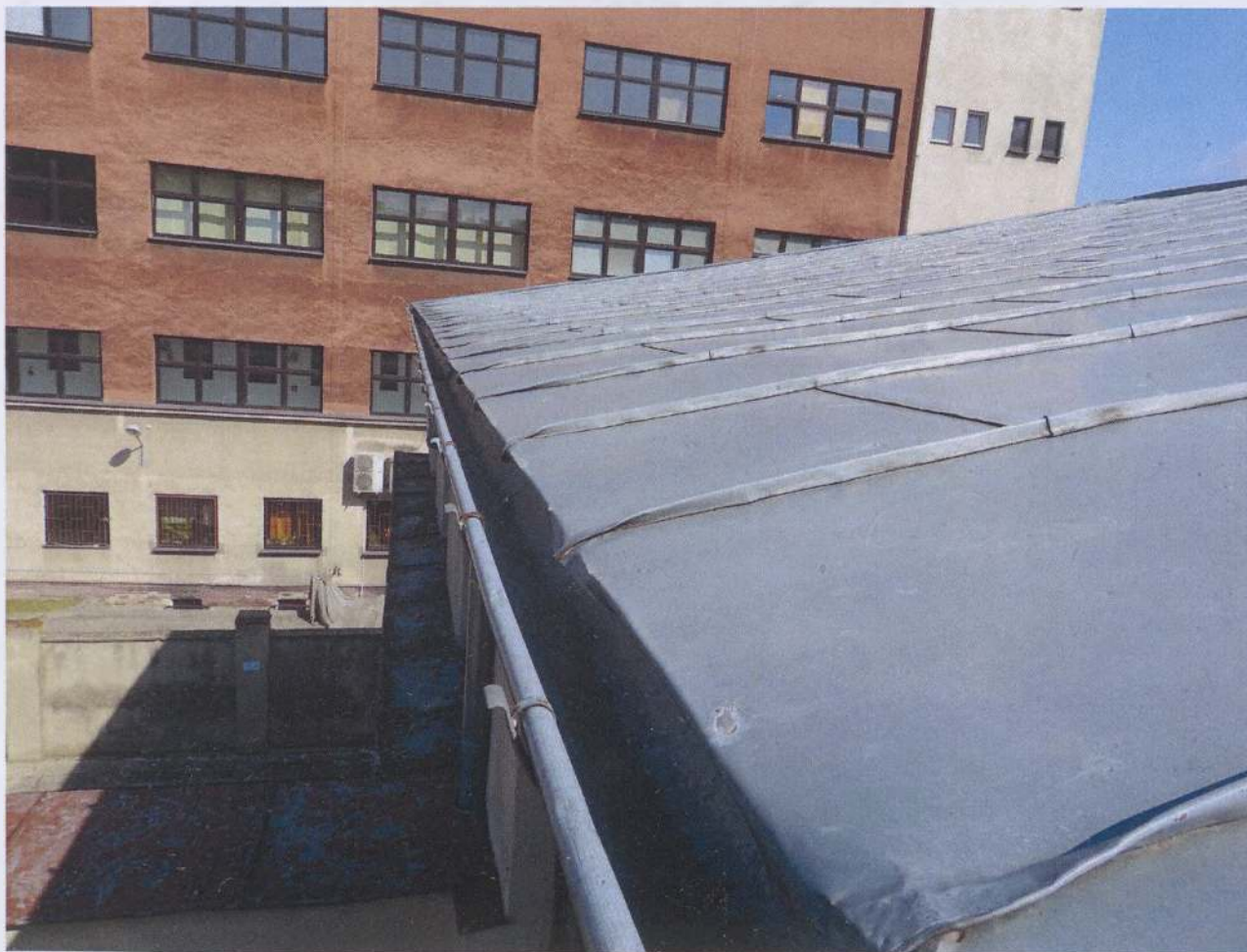
Niedokładne łączenie blach na rąbek stojący.
