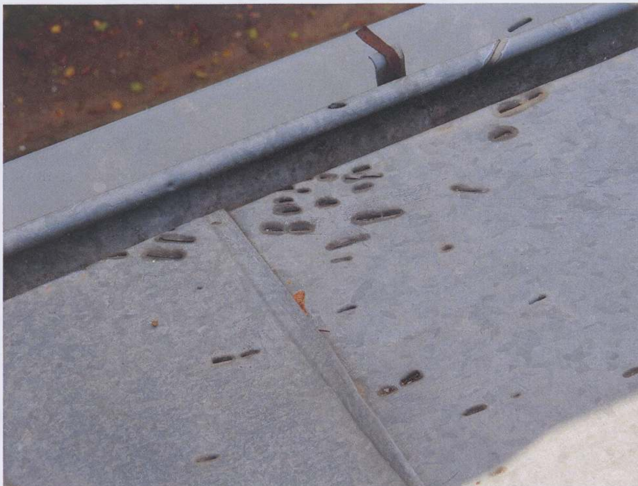
Perforacja blachy pokrycia
